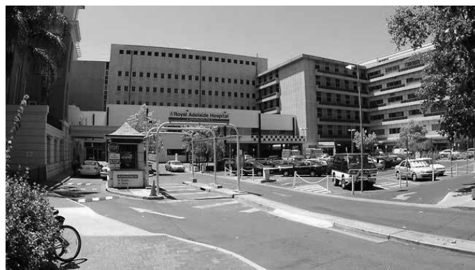
“Gamle” Royal Adelaide Hospital. Nytt sykehus skal stå klart høsten 2016.
